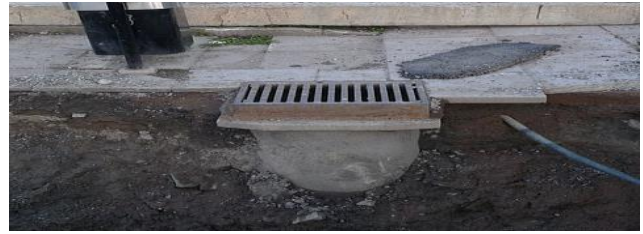
Fig. Storm Sewer
